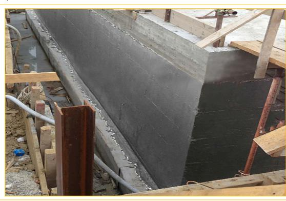
• Imperméabilisation de surfaces en béton ou maçonnerie, hors sol ou en sous-sol, telles que des puits, bassins, piscines, canaux, murs de fondation, caves et fosses d'ascenseur
